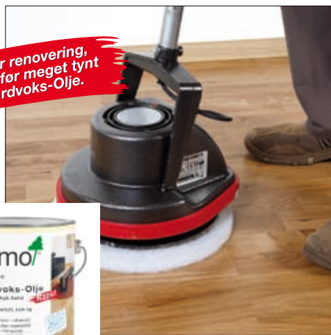
Enket å benytte en-padsmaskin for rask påføring
